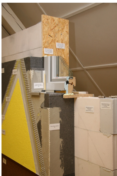
Stěny pasivních domů používané pro výuku a ukázky řešení pro pasivní a nulové domy
