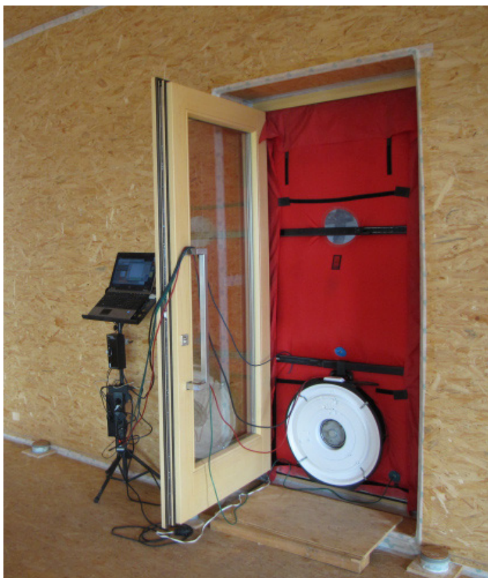
Zařízení pro měření průvzdušnosti domu blower-door testem (fotografie: AB Ateliér).
