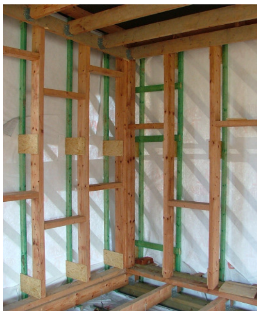
Nosná konstrukce z dřevěných sloupků, vnější konstrukce vynesena na páscích z OSB desek (Fotografie: AB Ateliér)
