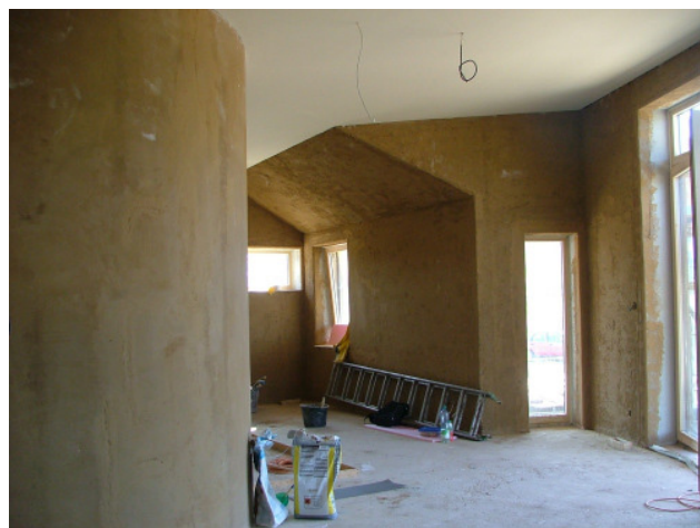
Hliněné omítky – zlepšení akumulace tepla a absorpce / desorpce vodní páry (fotografie: AB Ateliér)
