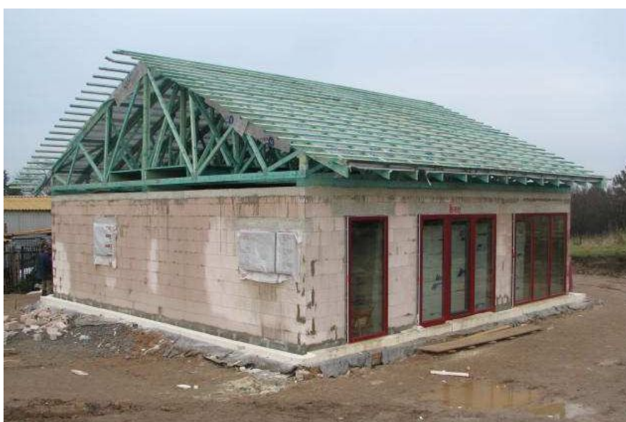
Stavba z předchozího obrázku s namontovanými střešními vazníky (fotografie: Kalksandstein CZ s.r.o.)
