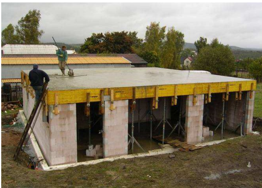
Masivní železobetonový monolitický strop – z vrchní strany bude doplněn foukanou tepelnou izolací, nad stropem bude lehké zastřešení na vaznicích, v interieru zachován pohledový beton (fotografie: Kalksandstein CZ s.r.o.)
