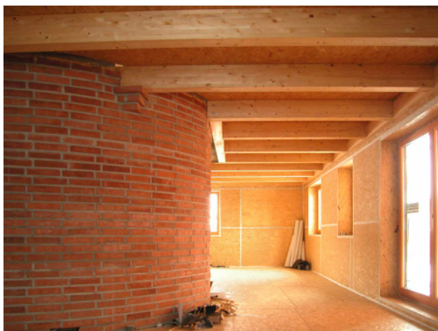
Vyzdívký z plných cihel pro zvýšení akumulace tepla v lehké dřevostavbě (fotografie: AB Ateliér)
